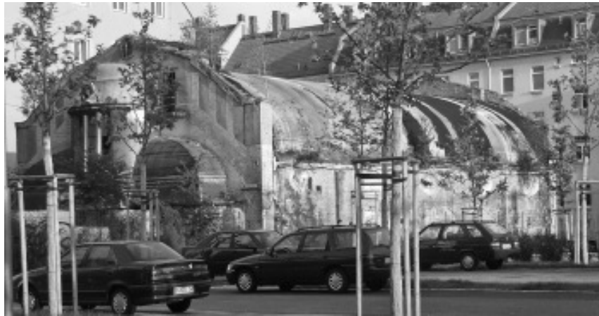
Der heutige Zustand: Die alte Markthalle mit dem prächtigen Portikus verfällt.
