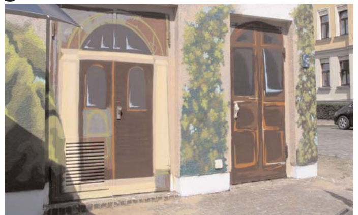
Als farbenfrohes nördliches Eingangstor zum Bülowviertel präsentiert sich nun das Transformatorhäuschen auf dem von Torgauer, Bautzmann- und Bülowstraße gebildeten Dreieckplatz.
