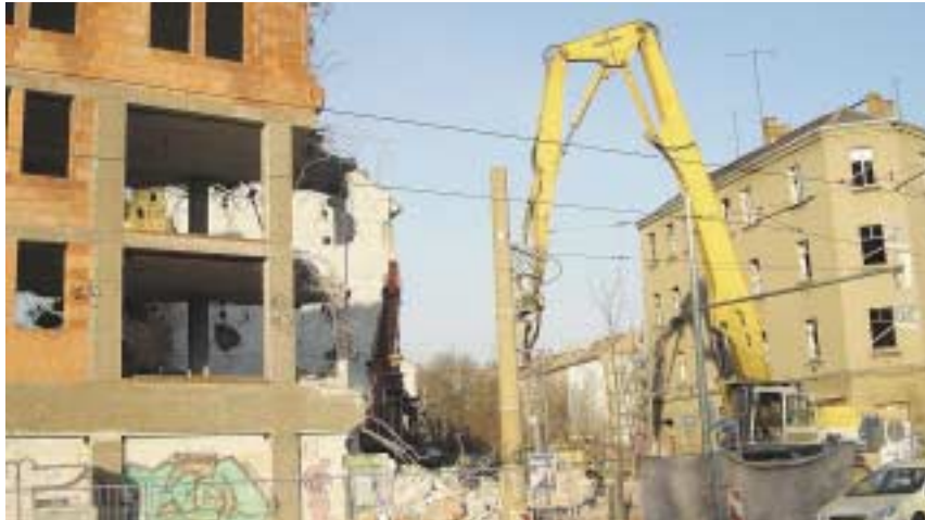
Das Ärgernis Investruine Wurzner Str. 79-81 fiel im Januar. Hier entsteht demnächst ein Stück „Lichter Hain“. Geplant ist dessen Erweiterung um Flächen an der Edlichstraße (rechte Bildhälfte).
