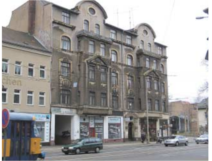
Das Vereinshaus Dresdner Str. 82 könnte sich zu einem der wirkungsstärksten Projekte einer Themen-AG (hier: Bauen und Wohnen) im Leipziger Osten mausern.
