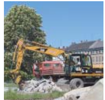
Ein neues Kleinspielfeld entsteht an der Stelle, wo früher das Ostbad stand.
