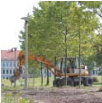
Mit großem Gerät werden Erdmassen zur Neumodellierung weiterer Parkbereiche bewegt.
