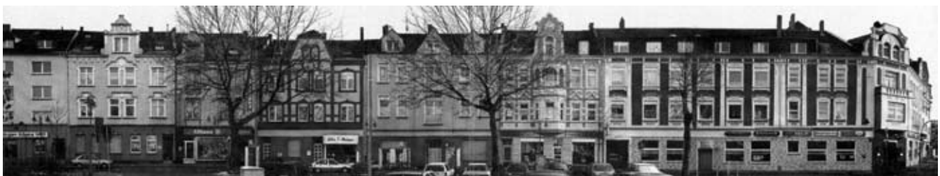
„Farbiger Stadtteil Marxloh“: Fassadengestaltungen August-Bebel-Platz Aufnahmen und Bildbearbeitung: Jean Lacasse, Duisburg
